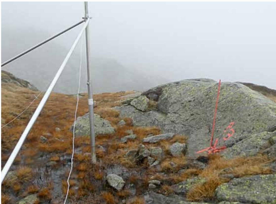
*Modinatura di una torre. Queste modine, che dovrebbero offrire l'idea di un'installazione alta 148 metri e larga al piede 7.5 metri, in realtà sono spesse 4 cm e sono alte non più di 6.50 metri. (Foto: Benedetto Antonini)*
