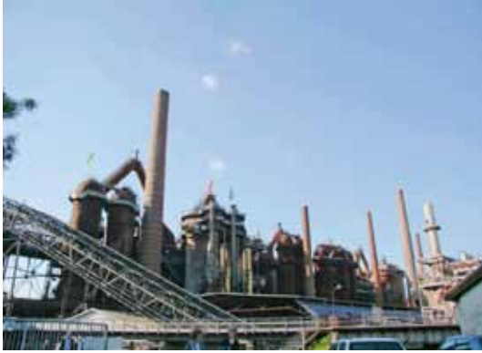
Völkingen (D): Hütte (impianto metallurgico), patrimonio universale. (Foto: Bernhard Furrer)
