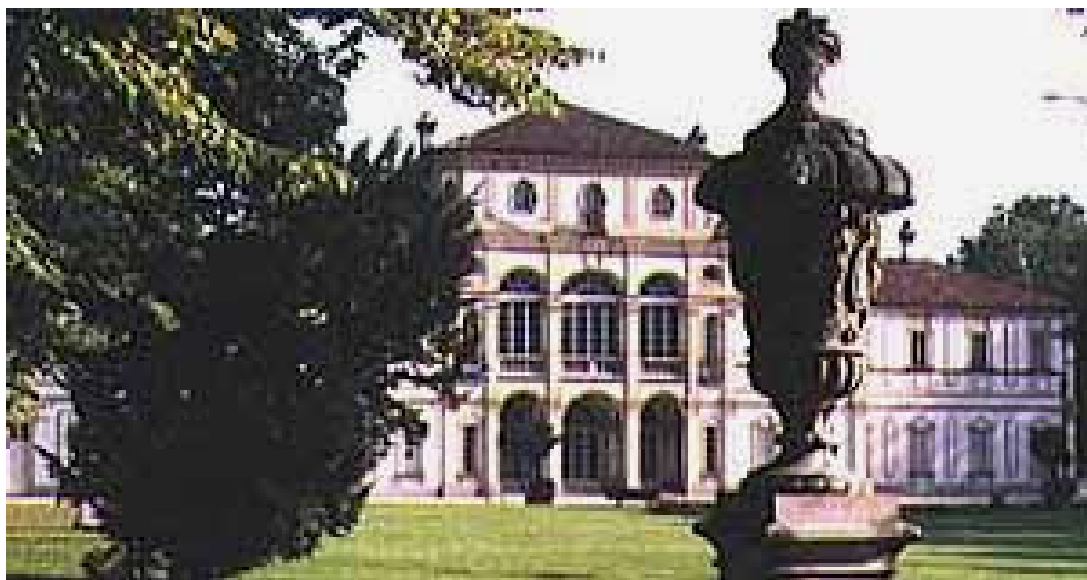
Fig 3 La Tesoriera , Torino- particolare di facciata
