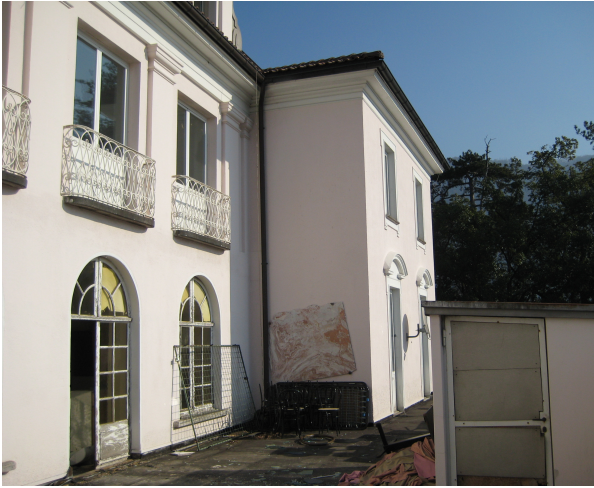
Facciata principale, esterno, stato attuale
